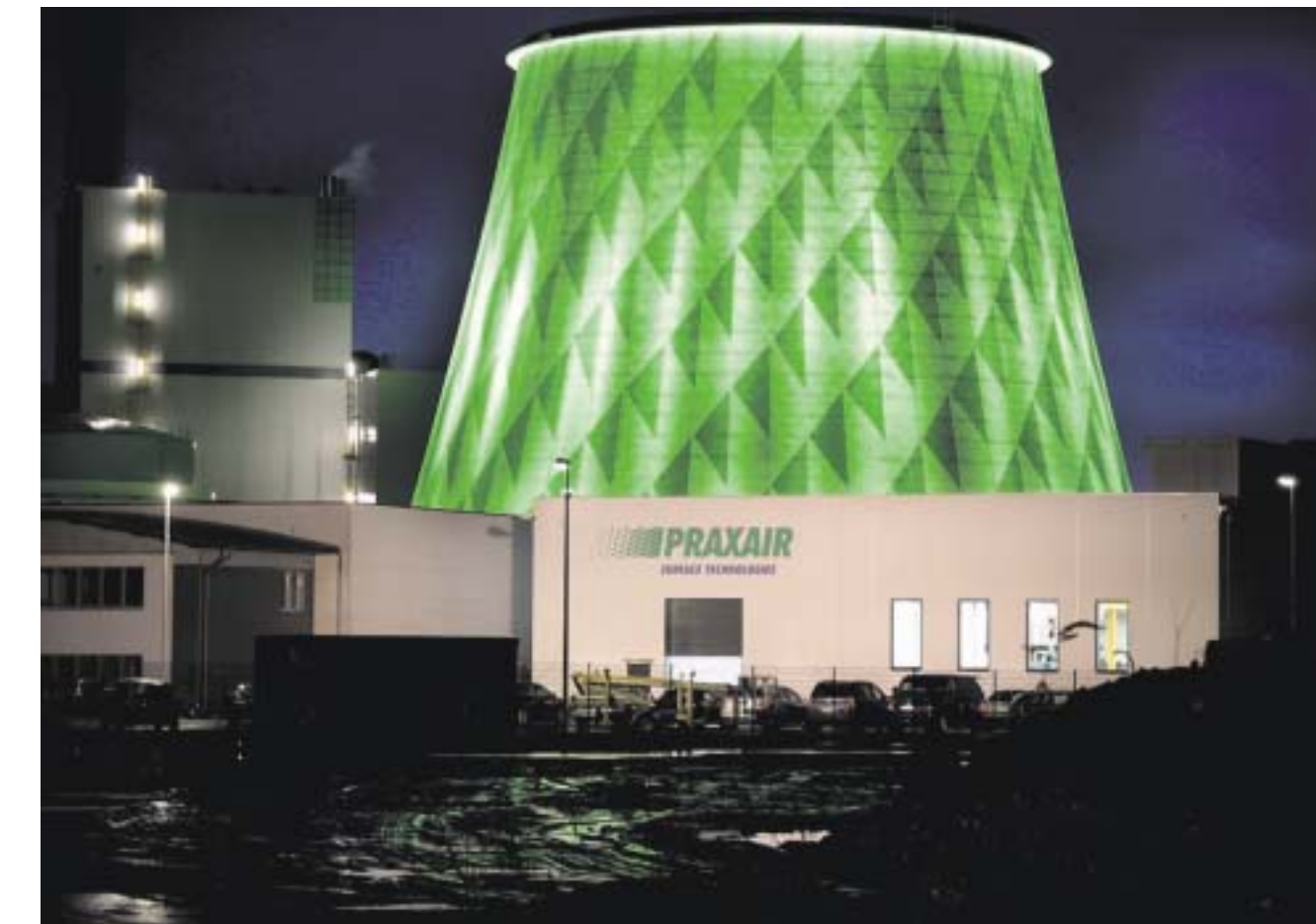
Ein neuer Teil der Wanheimer Industriekulisse ist die neue Praxair-Halle an der Neuenhofstraße. In der nächsten Woche startet das Unternehmen mit der Beschichtung von Metallteilen.
